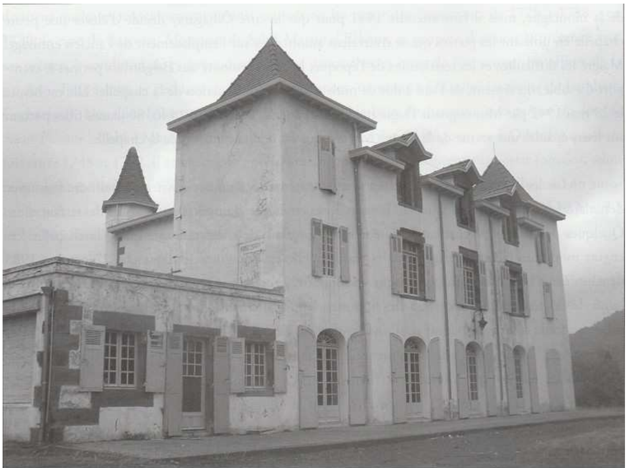
Fig. 1 : Vue d'ensemble du château d'Ascarat
